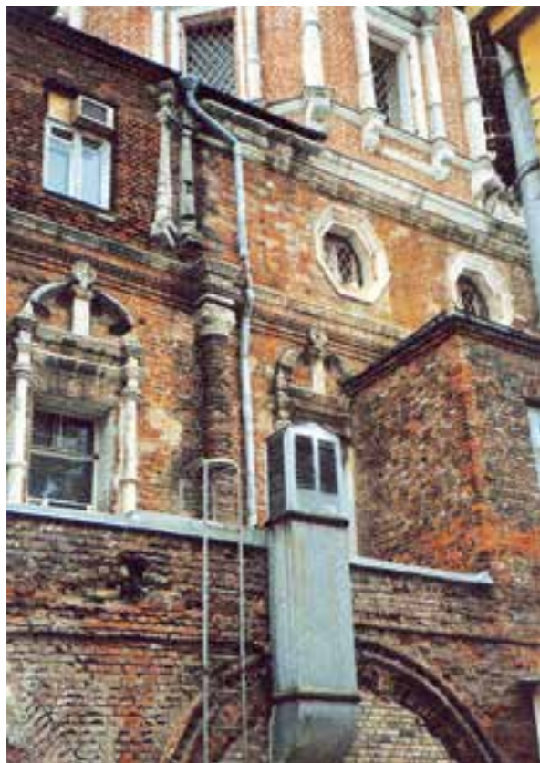
Часть южного фасада с поздними пристройками и закладками арок гульбища. Фотография 2007 года
